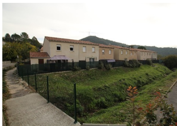
Logements sociaux au sud du village
