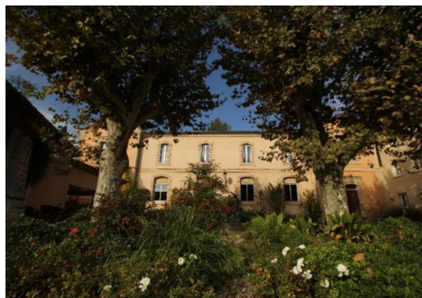
Habitat collectif à l'étage de l'ancienne école (logements communaux)
